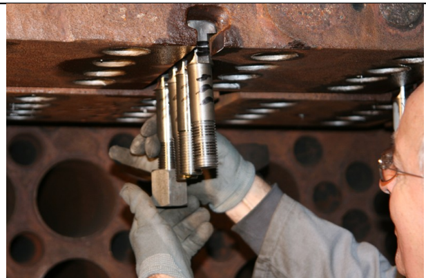
Remplacement des boulons supports de brides
